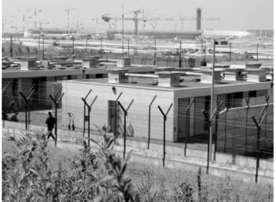
Centre de rétention administrative du Mesnil-Amelot, près de l'Aéroport de Roissy-CDG.
